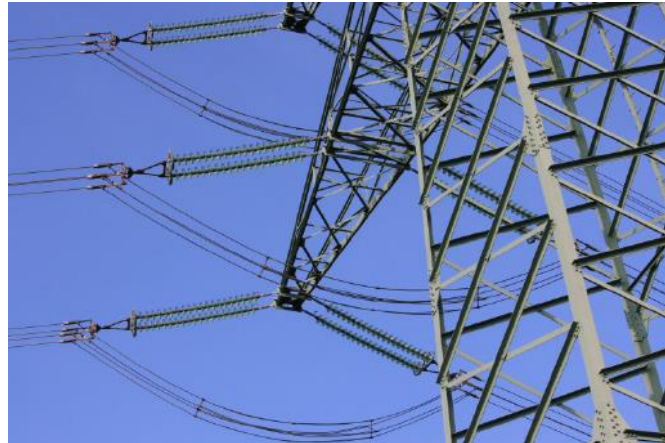
Abbildung 2: Blick in den Mast einer 380-kV-Leitung
